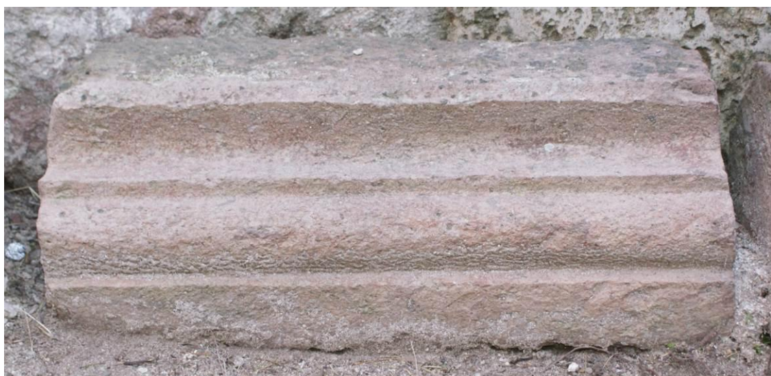
Εικ. Α5 Κατακείμενο μέλος γείσου από ιγνιμβρίτη με προφίλ που διαμορφώνεται με ταινία, σπείρα και κυμάτιο. Από το γείσο της βάσης του τρούλλου της αίθουσας προσευχής.
