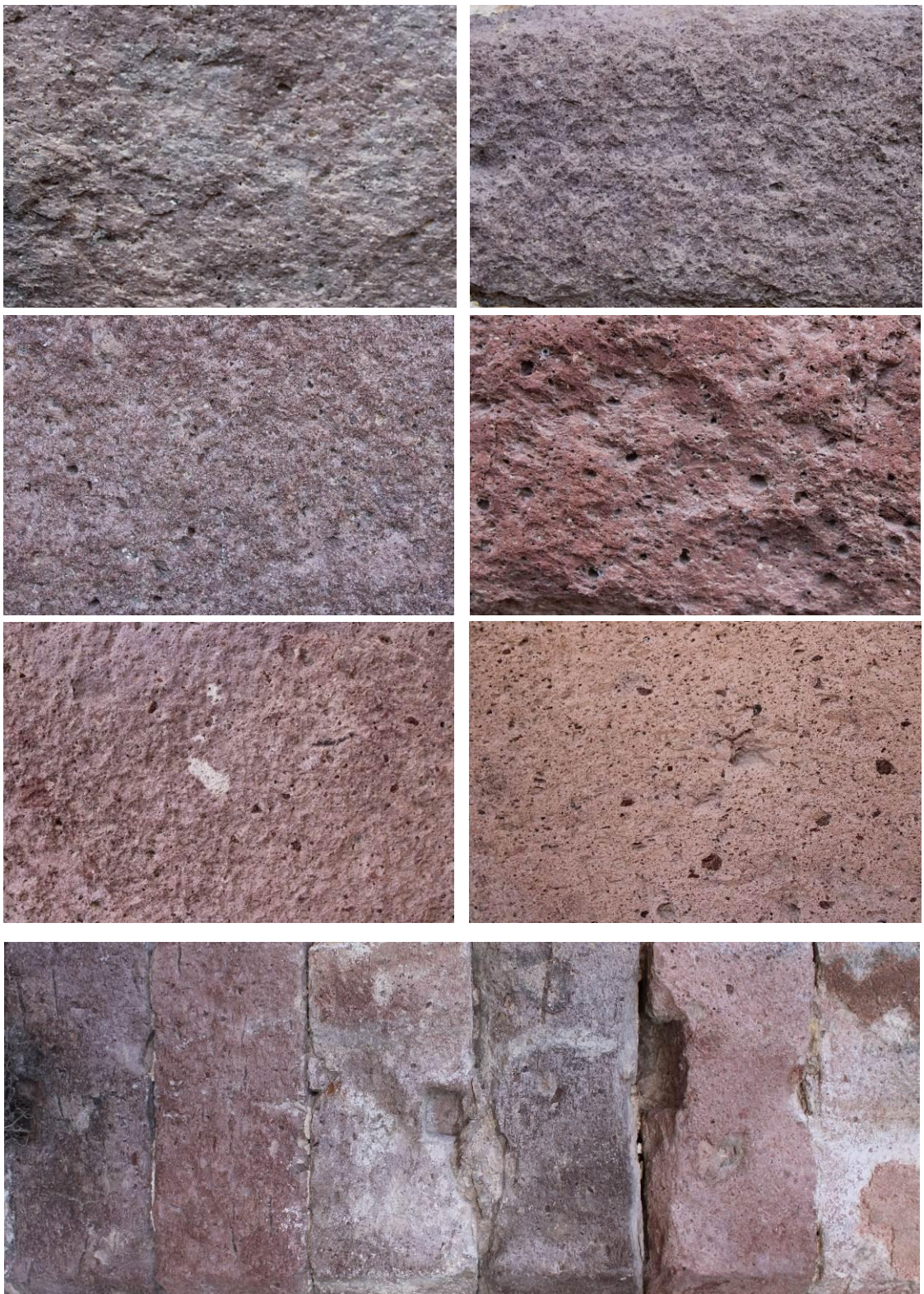
Εικ. Α3 Αποχρώσεις γνιμβρίτη που έχει χρησιμοποιηθεί για την κατασκευή του οθωμανικού Ιεροδιδασκαλείου.
