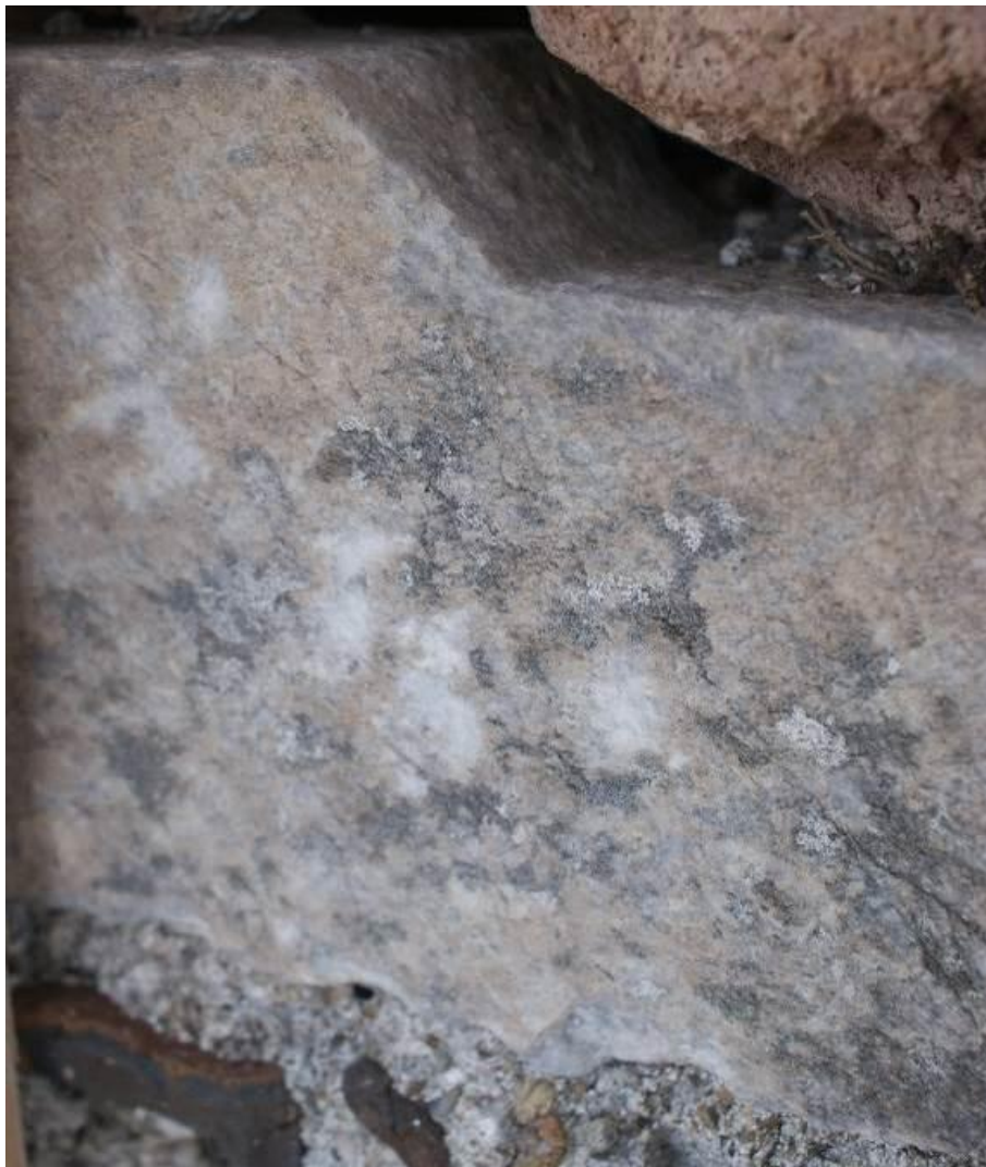
Εικ. Β17-Β18 Λεπτομέρειες ποδιάς πλαισίου παραθύρου από γκριζωπό μάρμαρο στον όροφο που σώζεται κατά χώραν (βορειοδυτική όψη του κτηρίου). Διακρίνονται οι λοξότμητες αποτιμήσεις για την προσαρμογή της δεξιάς παραστάδας του πλαισίου.
