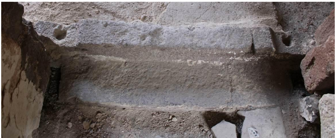
Εικ. Α19-Α21 Κατώφλια λαξευτών πλαισίων θύρας από ιγνιμβρίτη στον όροφο που διατηρούνται κατά χώραν. Διακρίνονται εσοχές κυλινδρικής διατομής (εντορμίες) για την προσαρμογή των παραστάδων.
