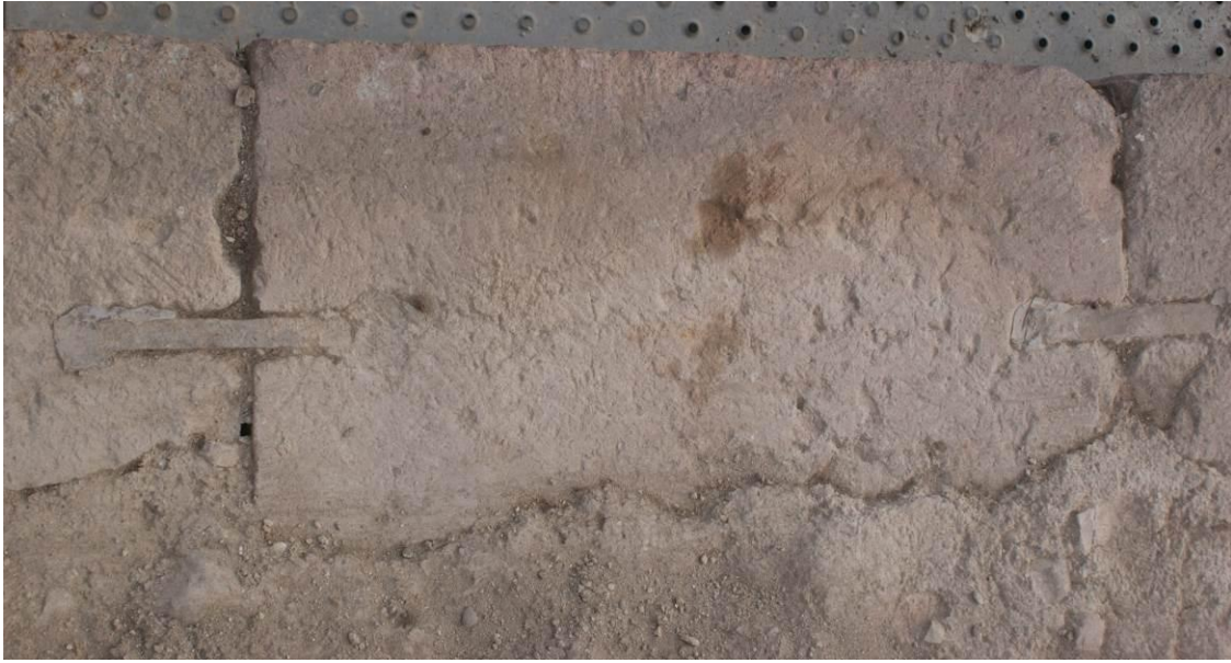
Εικ. Α10 Τμήμα του γείσου επίστεψης της στοάς στον όροφο (άνω όψη). Τα επιμέρους μέλη συνδέονται με πειόσχημους σιδηρούς συνδέσμους που διατηρούνται σε κακή κατάσταση σε όλη την έκταση του γείσου στο επίπεδο αυτό.
