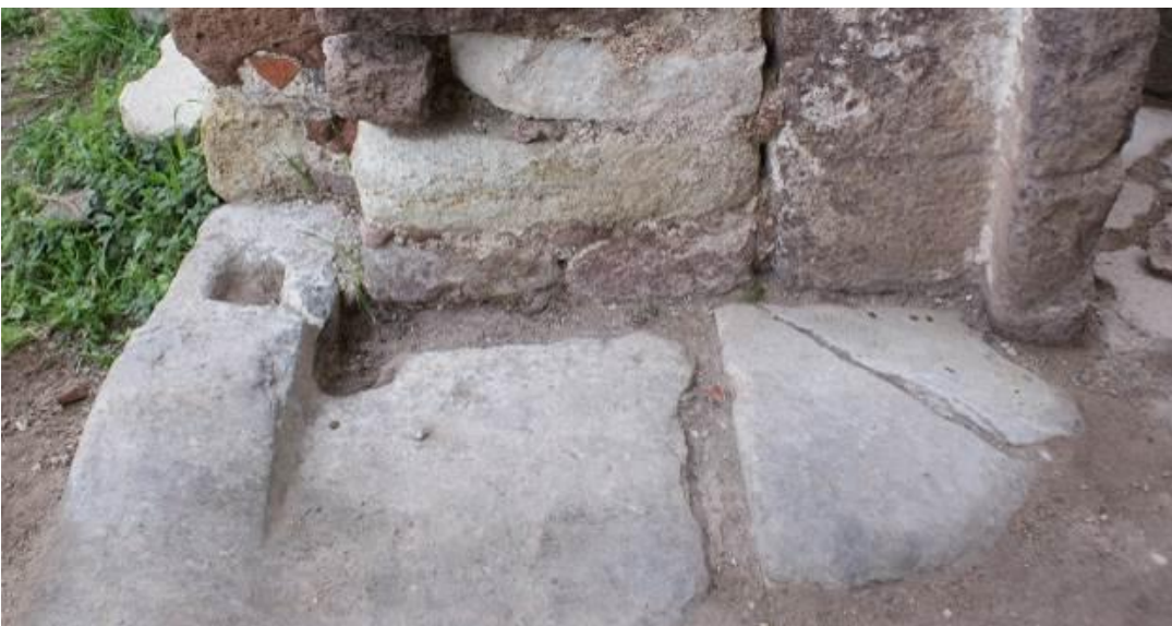
Εικ. Β9-Β10 Αυλόθυρα Οθωμανικού Ιεροδιδασκαλείου. Διατηρείται το κατώφλι από γκρίζο (κυανότεφρο) μάρμαρο που φέρει εντορμίες για την προσαρμογή των παραστάδων του πλαισίου, καθώς και οι εσοχές στην τοιχοποιία για την προσαρμογή των μαρμάρινων παραστάδων.
