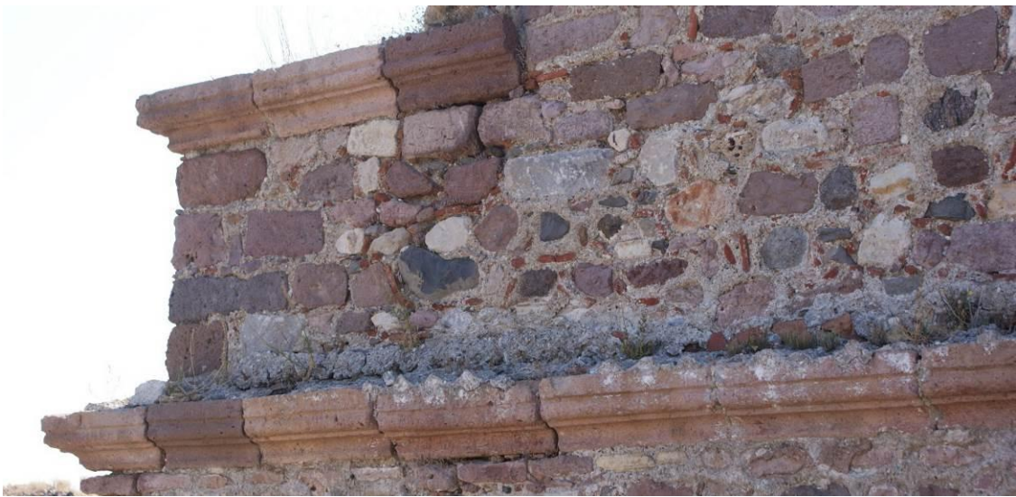
Εικ. Α6 Άποψη λαξευτού γείσου στη βάση και στην επίστεψη του κυβικού βάθρου του τρούλλου της αίθουσας προσευχής. Διακρίνεται η κλίμακα διαφορετικών αποχρώσεων του λίθου.
