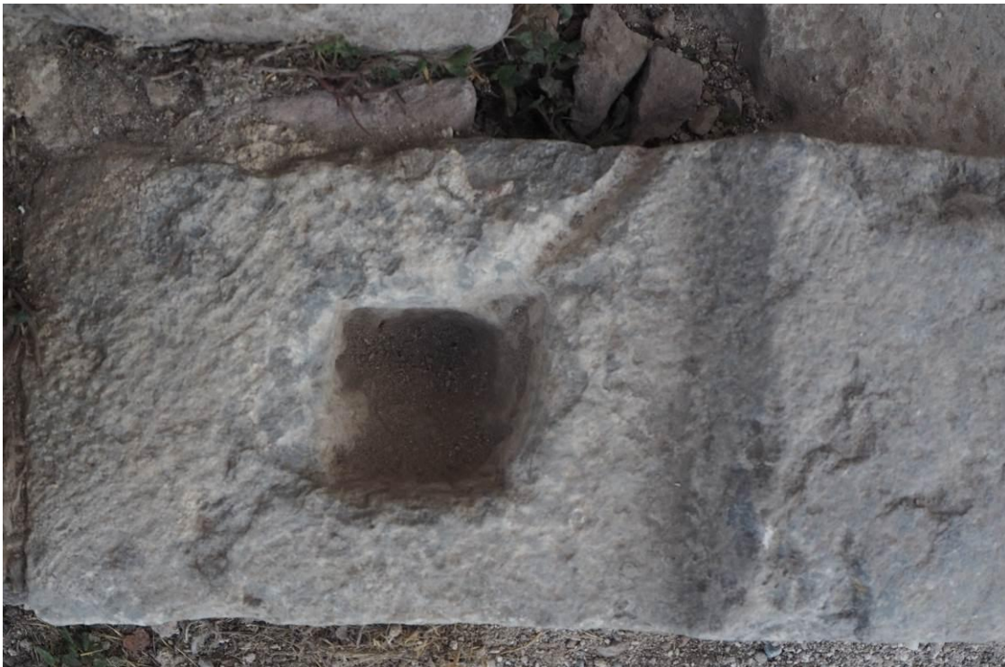
Εικ. Β8 Κατώφλι αυλόθυρας. Λοξότμητη απότμηση για την προσαρμογή της αριστερής παραστάδας του πλαισίου που φέρει εντορμία ορθογωνικής διατομής για τη σύνδεση των μελών.
