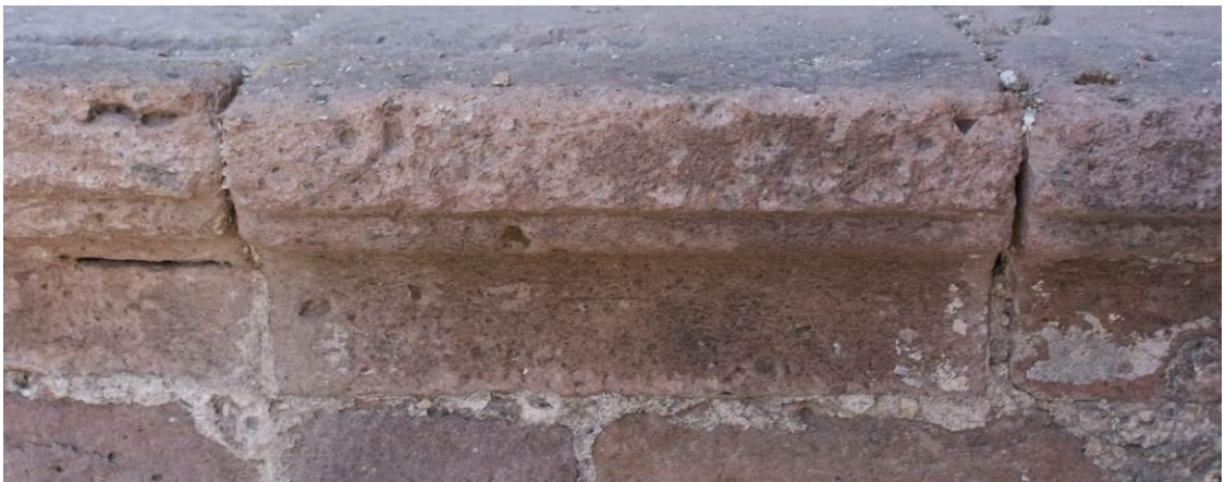
Εικ. Α7 Διατηρούμενο τμήμα του γείσου απλούστερης διατομής (χωρίς σπείρα) από την επίστεψη της στοάς στο ισόγειο.
