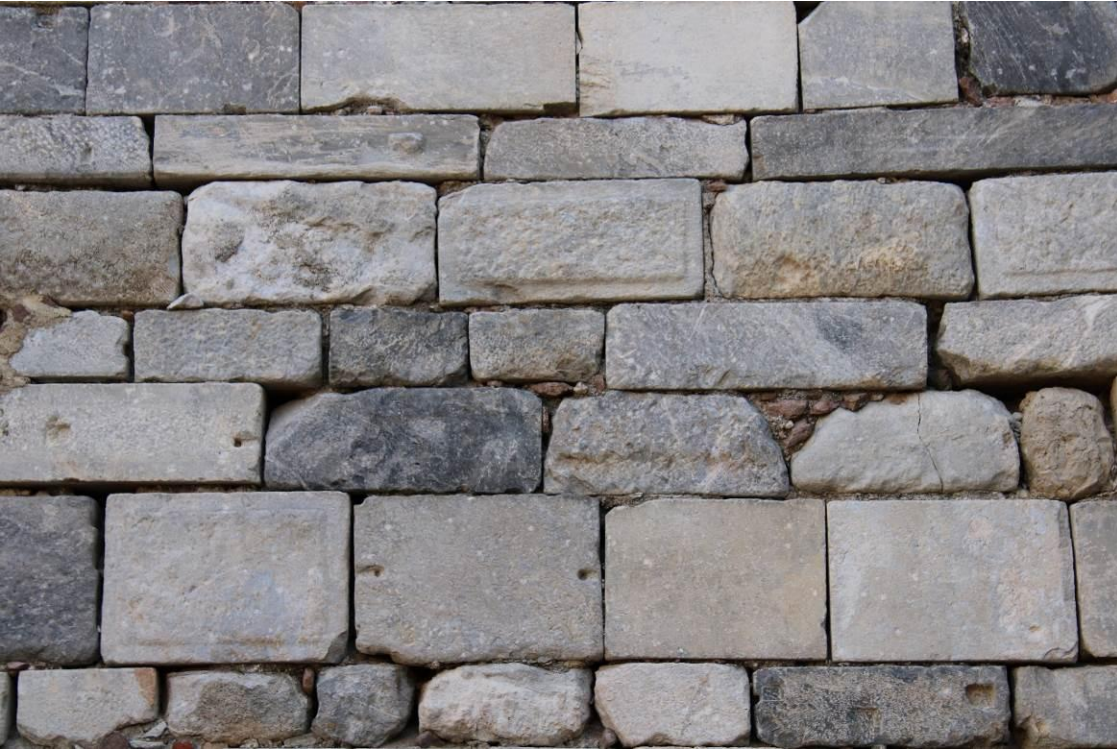
Εικ. Β1 Τμήμα εσωτερικής παρειάς τείχους στο Κάστρο Μυτιλήνης που δομείται από λαξευτά και ημιλάξευτα μάρμαρα. Διακρίνεται η χρωματική διαβάθμιση των γκριζωπών μαρμάρων που έχουν χρησιμοποιηθεί στις οχυρωματικές κατασκευές και στα κτήρια του κάστρου.
