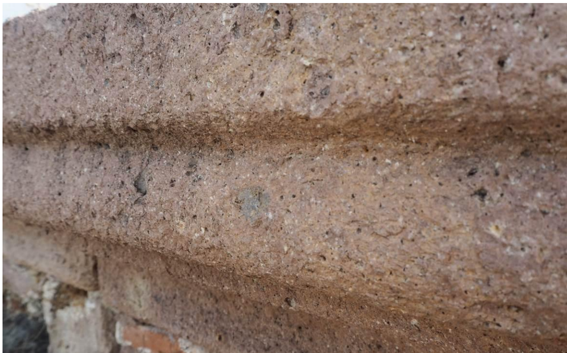
Εικ. Α4 Όψη κατεργασμένης επιφάνειας (χτυπητό) λαξευτού γείσου από ιγνιμβρίτη (γείσο επίστεψης
