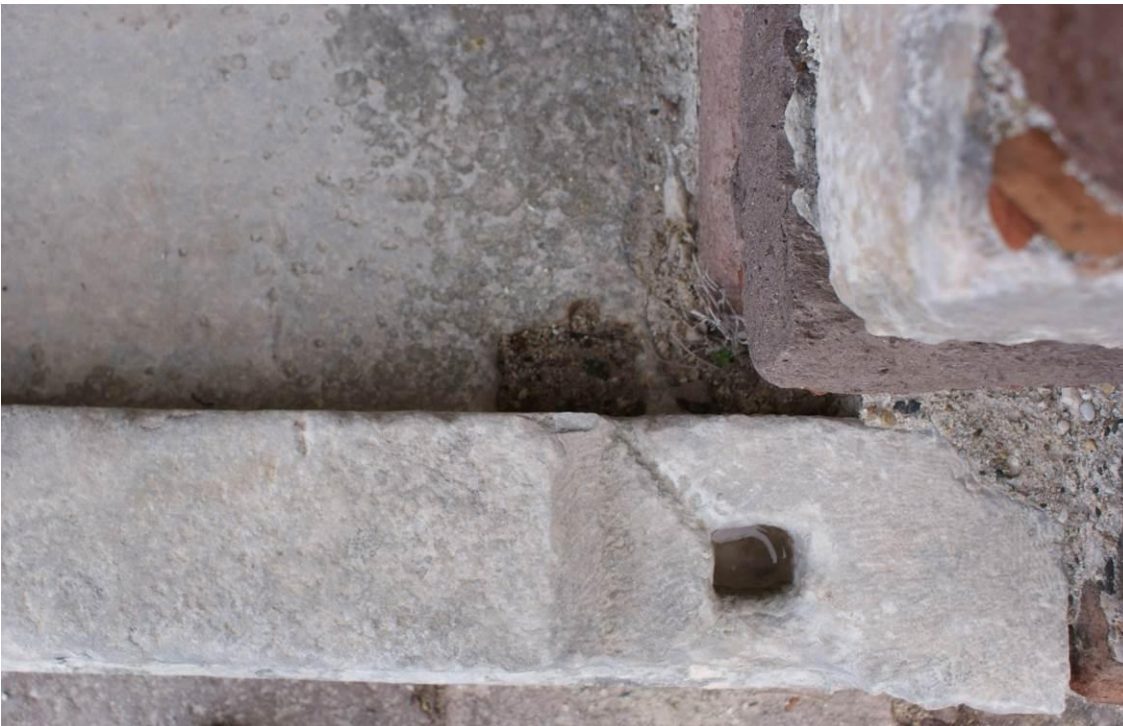
Εικ. Β6 Το κατώφλι της εισόδου στην αίθουσα προσευχής από λευκόφαιο μάρμαρο. Διακρίνεται η λοξότμητη απότμηση για την προσαρμογή της δεξιάς παραστάδας του πλαισίου που φέρει εντορμία ορθογωνικής διατομής (σύνδεση με μαρμάρινη παραστάδα). Εσωτερικά διακρίνεται επίσης εντορμία προσαρμογής ξύλινου κουφώματος σε επαφή με την παραστάδα.
